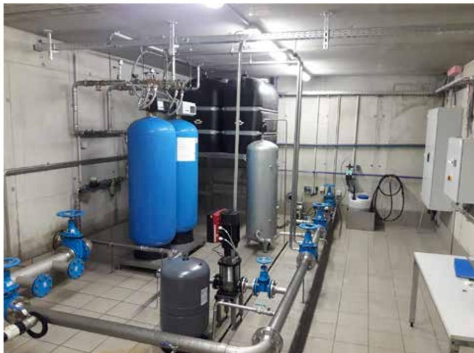
Zuerst wird dem Wasser in geringer Menge eine Kaliumpermanganat-Lösung zugesetzt. In weiterer Folge wird Luft in das Wasser eingeperlt. Dadurch werden die Eisen-Ionen und die Mangan-Ionen soweit oxidiert, dass sie im nachfolgenden Prozess über einen speziellen Kiesfilter aus dem Wasser entfernt werden können.
